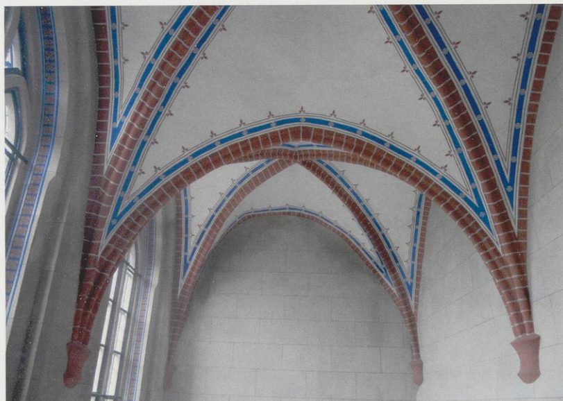
7 Restaurierte Decke in der Bibliothek
